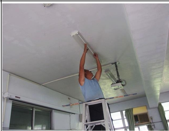
說明：汰換省電燈管，以節約用電
