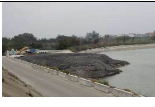
說明： 滯洪池畔施工工地
