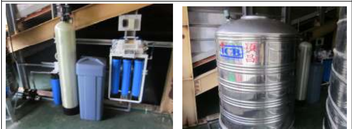
說明：施工後(施工位置)
