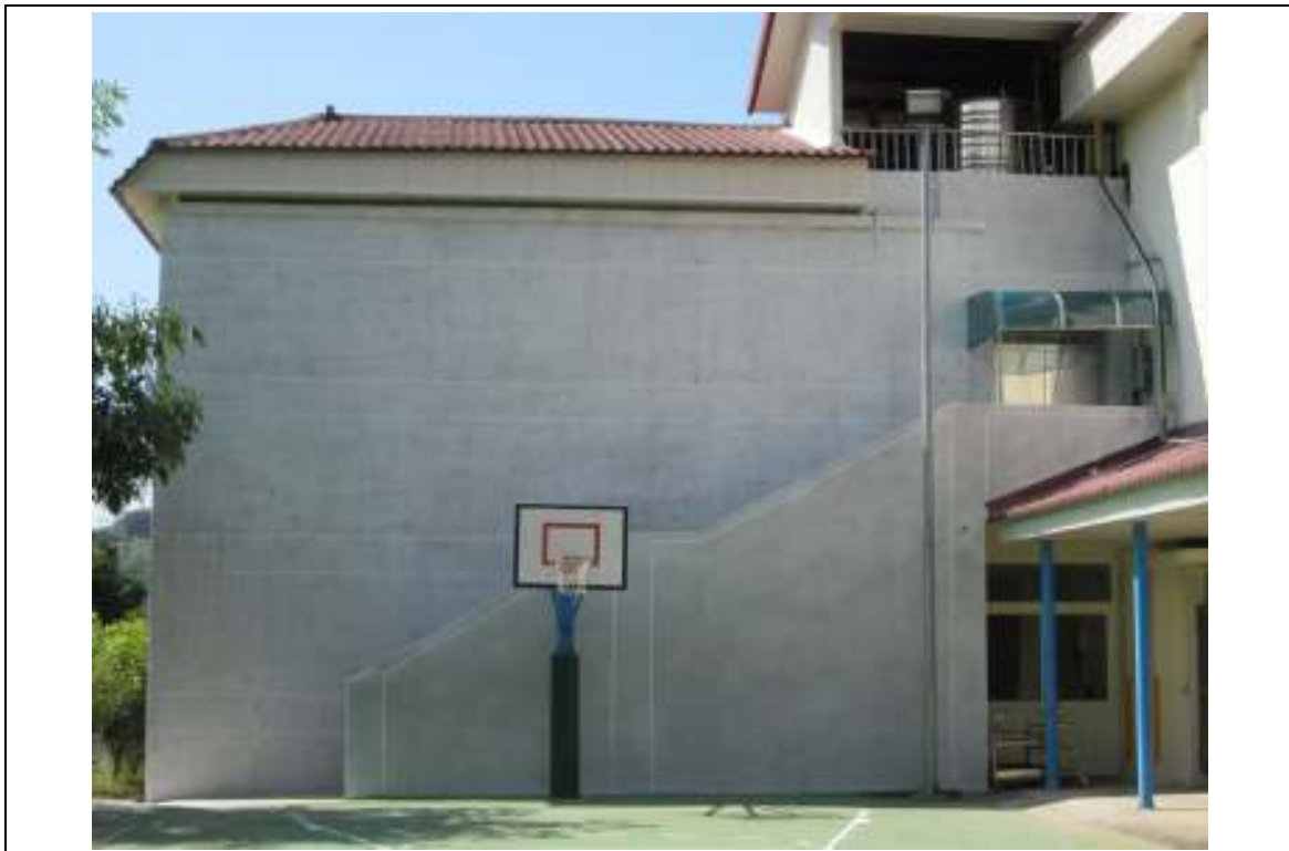
說明：施工前(水塔外觀)
