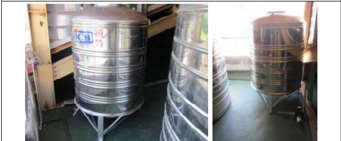
說明：施工中(施工位置)
