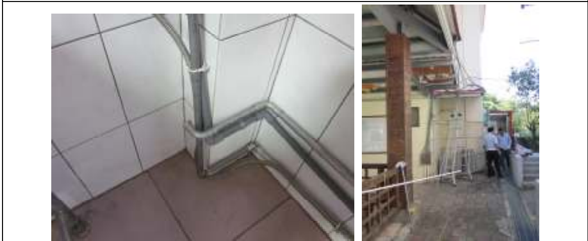
說明：施工中(管線施工)，廚房用水配管，準備不鏽鋼管
