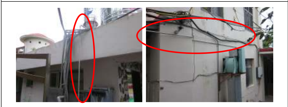
說明：施工後(管線施工)，圈起處為不鏽鋼管
