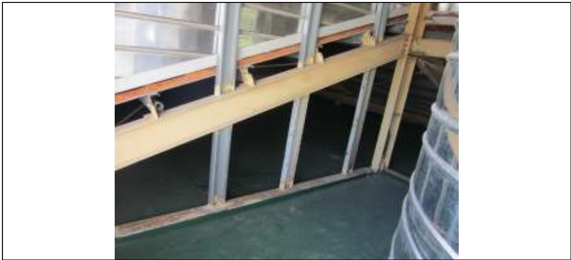
說明：施工前(施工位置)
