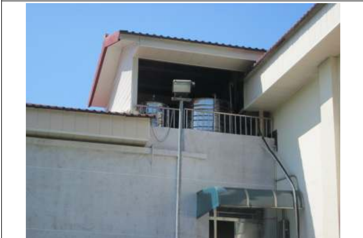
說明：施工後(水塔外觀)
