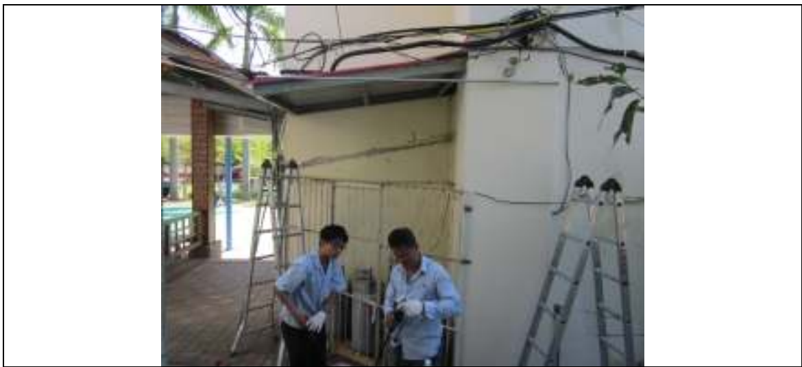
說明：施工前(管線施工)
