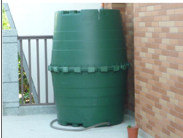
說明：二樓自然教室旁的雨水回收槽
